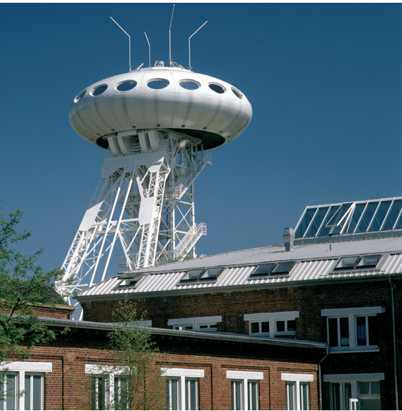
Förderturm der Zeche Minister Achenbach, Schacht IV in Lünen, bis 1991 in Betrieb. Das 2001 fertig gestellte Gründerzentrum LÜNTEC befindet sich im sog. Colani-Ufo, einem auf das ehemalige Fördergerüst aufgesetzten Ellipsoid.
