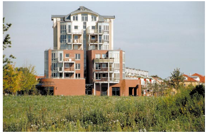
Wohnungsbau in Stahnsdorf bei Berlin
