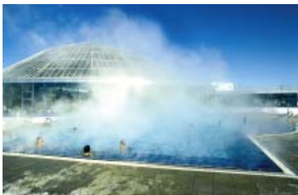
Nutzung von Geothermie aus 2300 m Tiefe im Thermalbad in Erding
