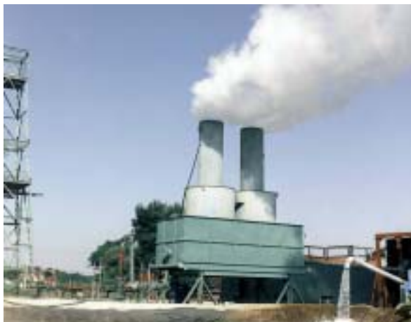
Dampferzeugung im Europäischen Hot-Dry-Rock Forschungsprojekt Soultz-sous-Forêts im Elsaß
