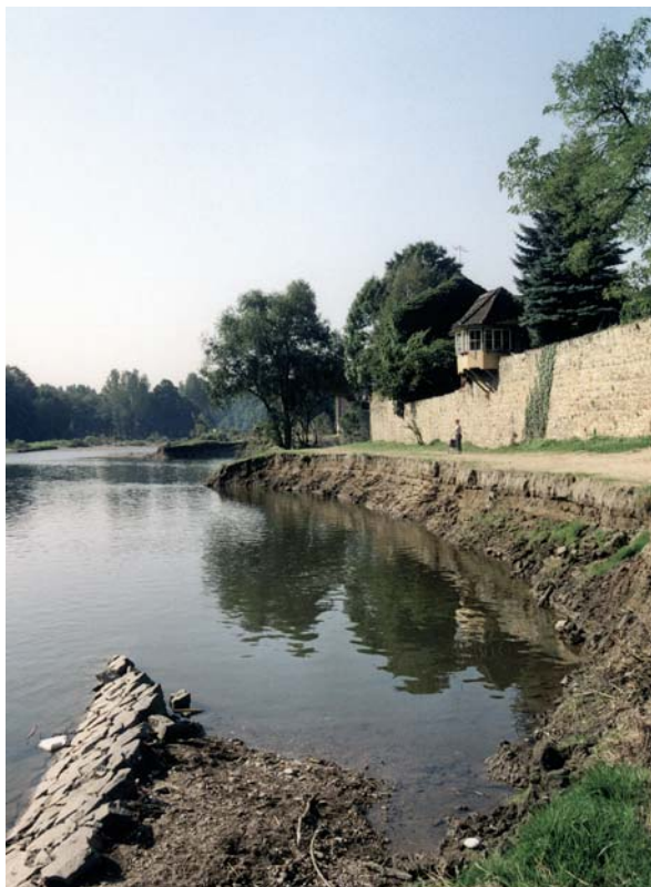
Grimma (Sachsen) nach dem Muldehochwasser vom August 2002 – Teile der Uferbefestigung wurden z.T. bis zur Stadtmauer weggerissen (Aufnahme Sept. 2002).
