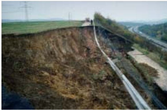
Rutschung an einem künstlichen Hang an der A 61 bei Bonn in tief verwitternden devonischen Gesteinen
