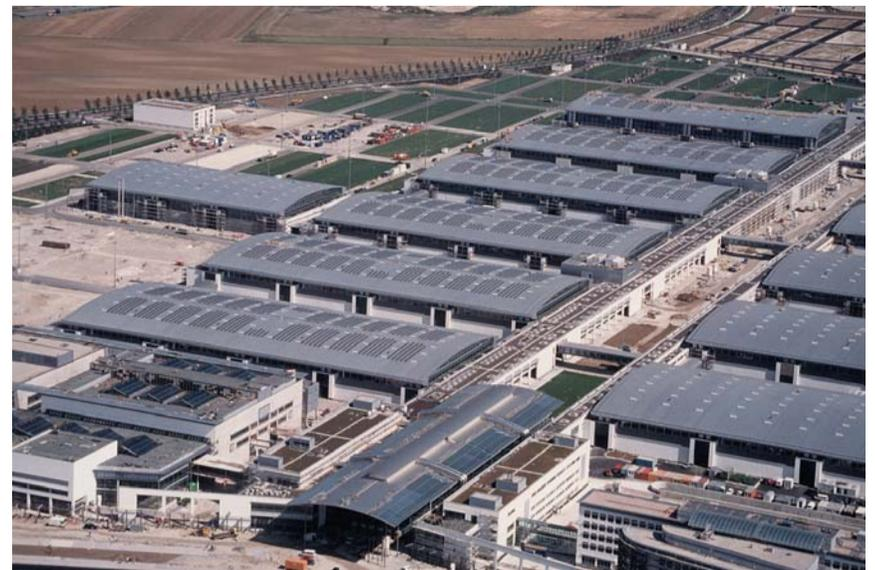
• Eine Megawatt-Photovoltaik-Anlage: Die weltgrößte Dach-Solaranlage wurde 1997 auf den Hallen des neuen Münchener Messegeländes in Betrieb genommen: 66.000 m<sup>2</sup> mit 7812 Solarstrom-Modulen und einer Gesamtleistung von 1016 kW
