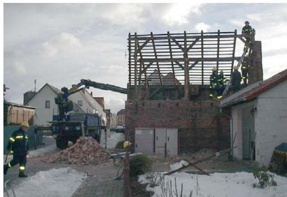
Sturmschäden an Dächern und Autos können in allen Gegenden Deutschlands auftreten.
